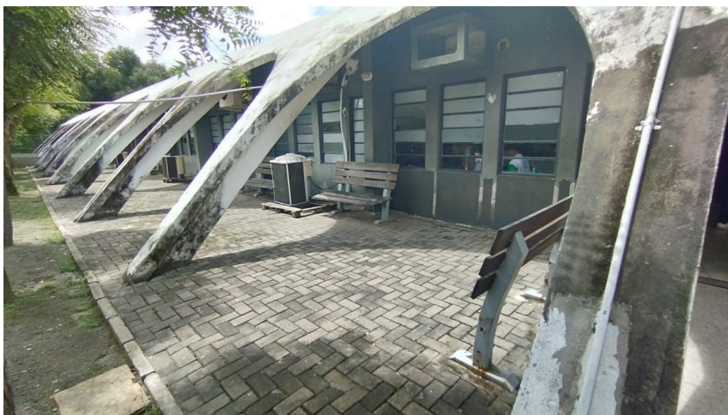
Figura 20: Estrutura de cobertura feita de concreto no IFPI - CTZS. Fonte: Arquivo pessoal da autora, 13 de março de 2024.
